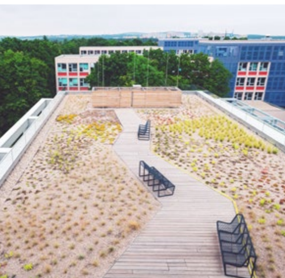
Pavilon tropického zemědělství České zemědělské univerzity byl navržen s ohledem na dlouhodobou udržitelnost budovy. Její součástí jsou tepelná čerpadla, retenční nádrže na dešťovou vodu, fotovoltaické panely a také zelená střecha. FOTO: NADACE PARTNERSTVÍ / VOJTA HEROUT
