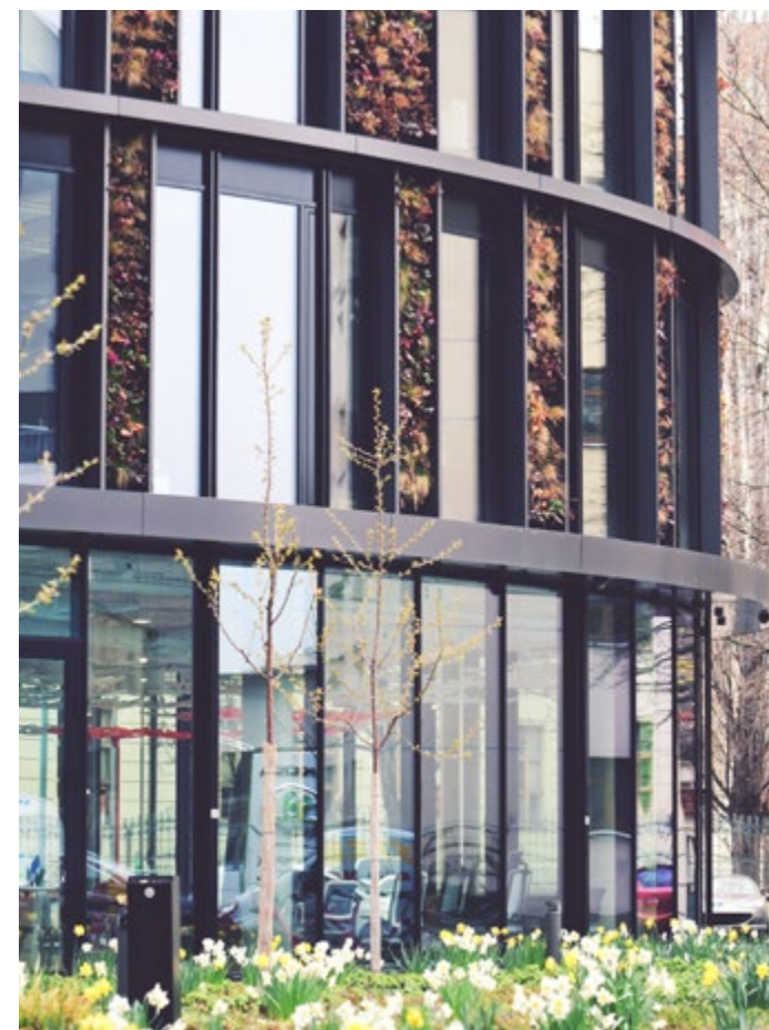
Zelené fasády jsou stále oblíbenější pro použití na nových kancelářských budovách. FOTO: ANTONÍN KEPRTA, OCP MHMP
