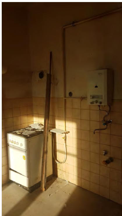
Byt před rekonstrukcí
